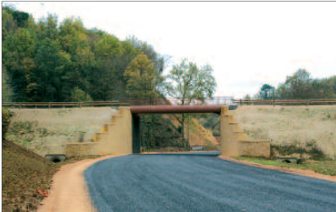
Dans le vallon des Peyrouses, un ouvrage a dû être construit
